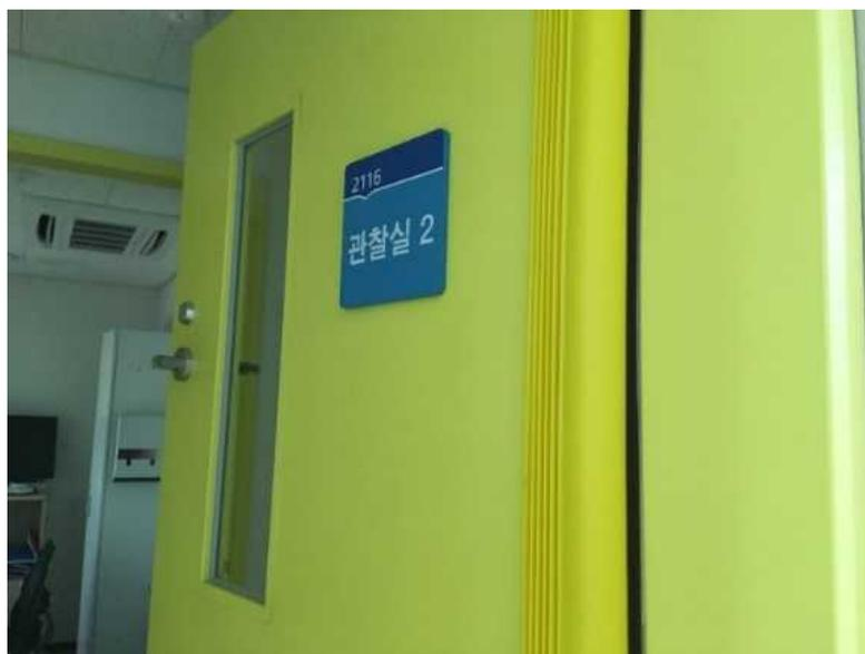
그림 2. 손끼임 방지 측면 보호대를 사용하여 경첩 노출을 제한한 예시
