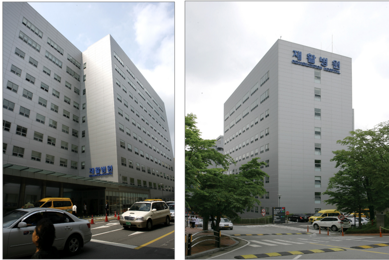
사진 35. 증축 후 재활병원 전경 (전면 및 옆면).
