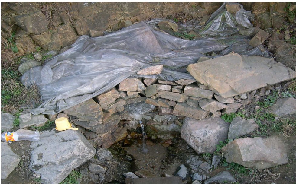
Fig. 21-1. 먹는 물 공동 시설 주변 현황의 예.
